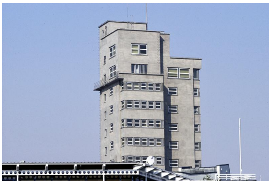
Betonfassadensanierung am Tagblattturm in Stuttgart
