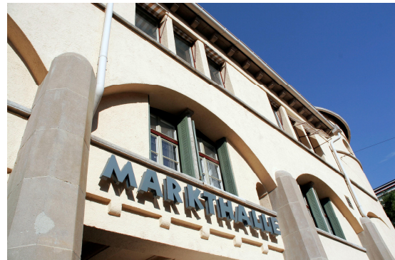
Fassadensanierung an der historischen Markthalle Stuttgart
