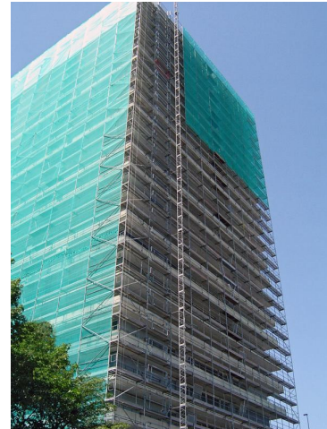
Fassaden- und Balkonsanierung Wohnhochhaus „Zollhofstraße“ in Sindelfingen
