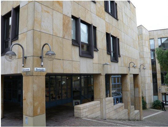
Sanierung der Sandsteinfassade am Rathaus Böblingen
