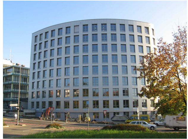
Für den Neubau des Landratsamts Friedrichshafen plante Sulzer die komplette Elektroinstallation inklusive Trafostation, Notstromversorgung, KNX-Technik, Brand- und Datentechnik.
