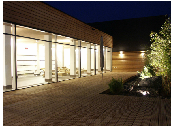
Saunagarten des Hallenbades und der Sporthalle in Mengen
