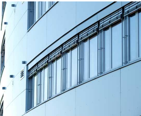
Für die Versorgung der Arbeitsplätze im Büro- und Laborgebäude der Contitemic in Markdorf entwickelte das Ingenieurbüro ein flexibles System.
