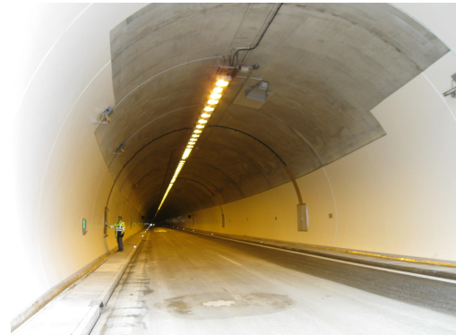
Sanierter Teilabschnitt des Hohentwiel隧unnels
