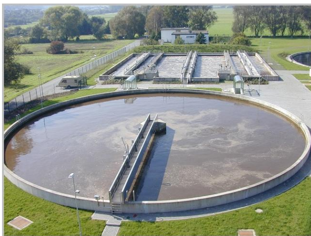
Denitrifikations-und-Nitrifikationsbecken
