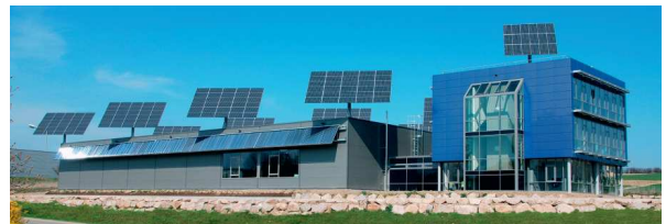
Verwaltungsgebäude der DEGERenergie GmbH in Horb
