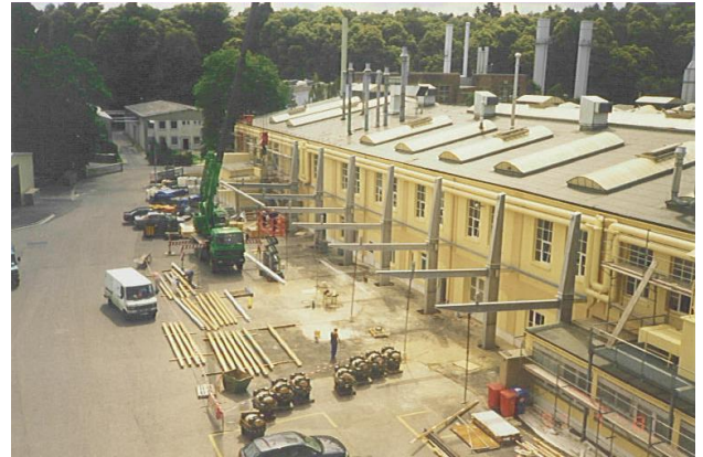
Anbau einer Überdachung für Wareneingang und Versand
