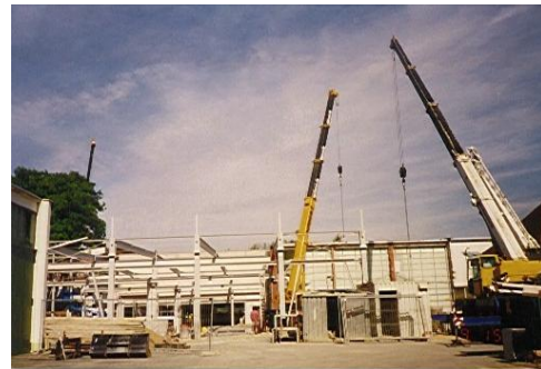
Neubau eines Fertigungsgebäudes
